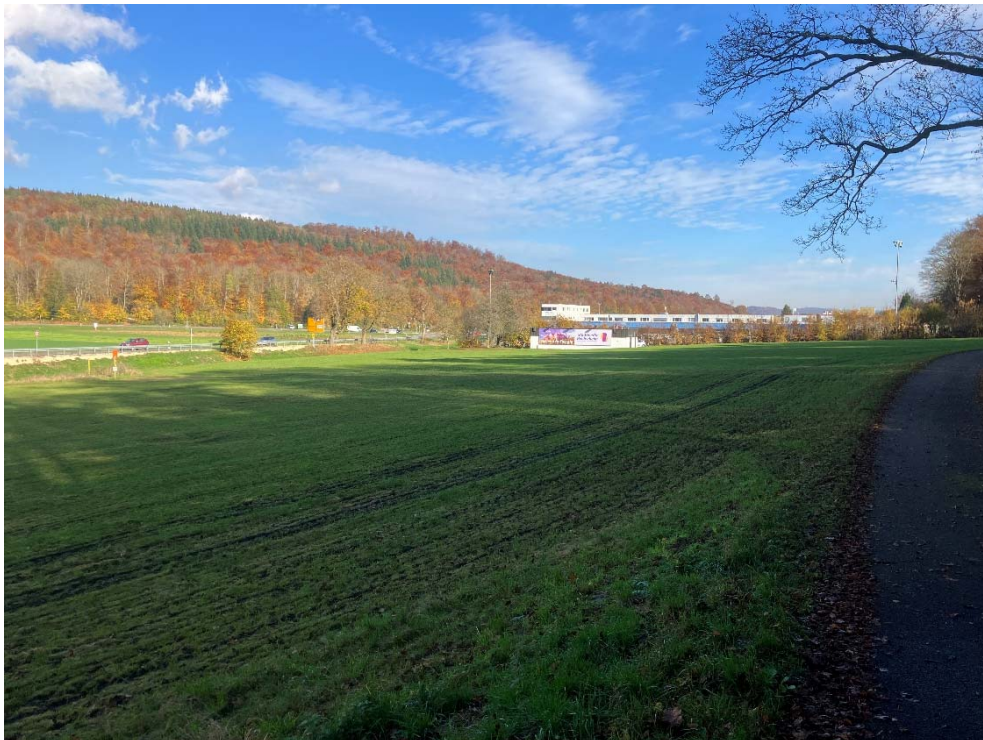
Abb. 5: Foto aus südwestlicher Richtung (Stadtwerke Heidenheim)
